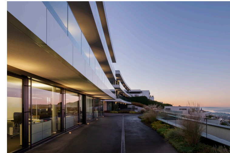
Wohn- und Geschäftshaus, Schindellegi Baujahr: 2019
