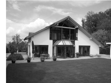
Umbau Wohnhaus, Wilen Baujahr: 2018
