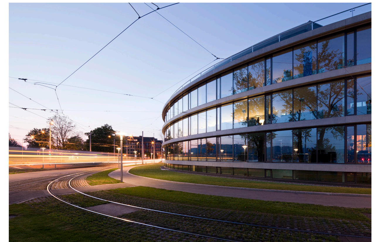
Geschäftshaus, «Bellerive», Zürich Baujahr: 2007
